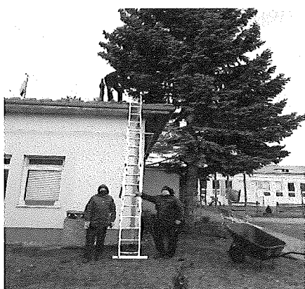
Čistenie zvodov rýny
