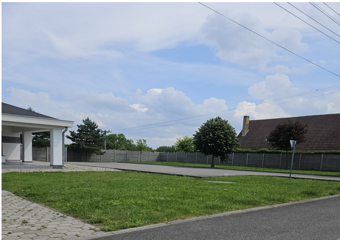
Novovytvárané betónové oplotenia v obci – 2023
