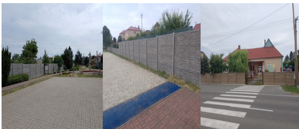
Novovybudované betónové oplotenia v obci - 2022
