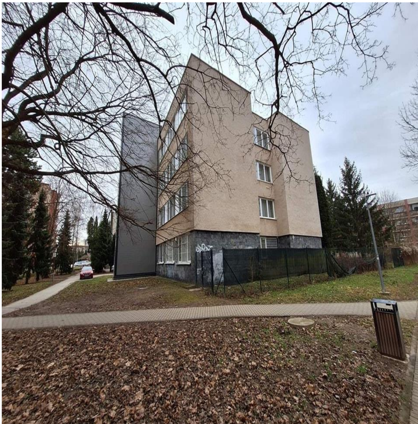
Zariadenie sociálnych služieb pred rekonštrukciou
