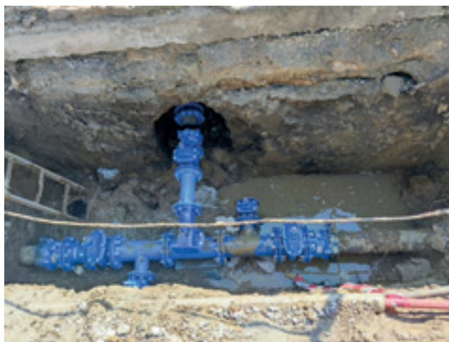
Uzlové body na verejnom vodovode - M. Benku - pred budovou školy
