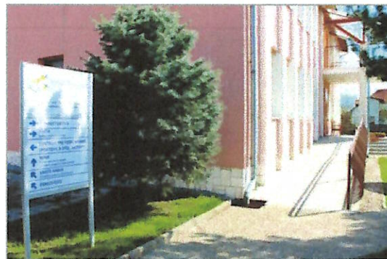
Obrázok 5: Bezbariérový prístup do domu PINTA
