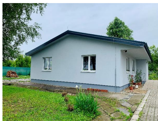
Novopostavená budova pre rozvoj pracovných zručností
