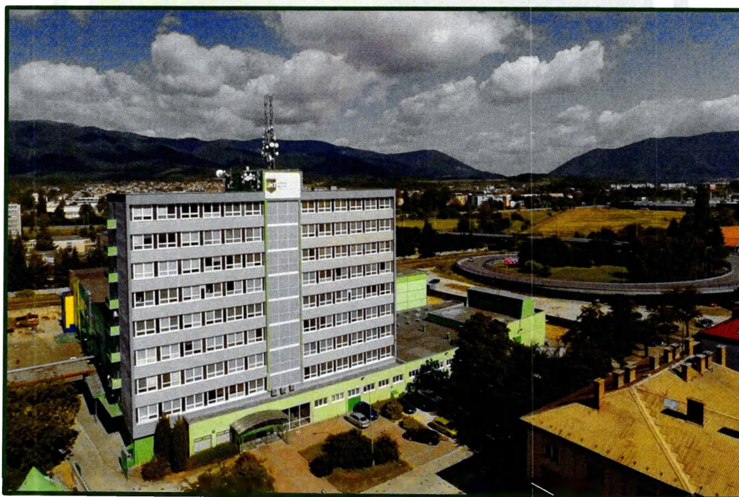
Pohľad na administratívnu budovu
