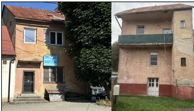
budova č.s. 41 pôvodný stav
