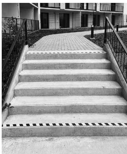
Schodisko bytového domu s kontrastným žltočiernym náterom.
