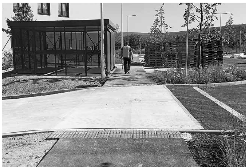
Varovné pásy označujúce rozhranie chodníka a vozovky.
