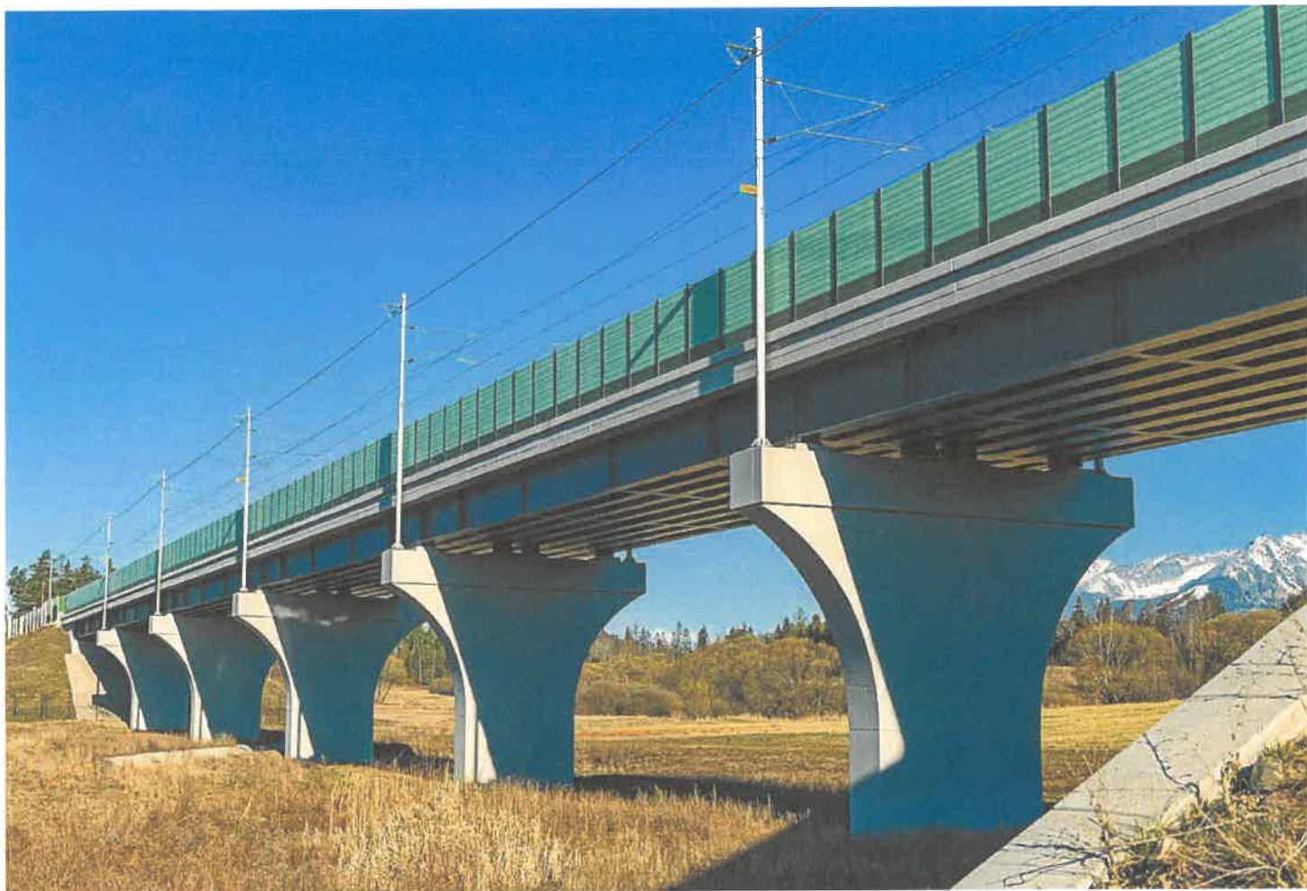
Modernizácia železničnej trate Žilina – Košice, úsek trate Liptovský Mikuláš – Poprad Tatry (mimo), 1. etapa, úsek Poprad – Lučivná, investor ŽSR
