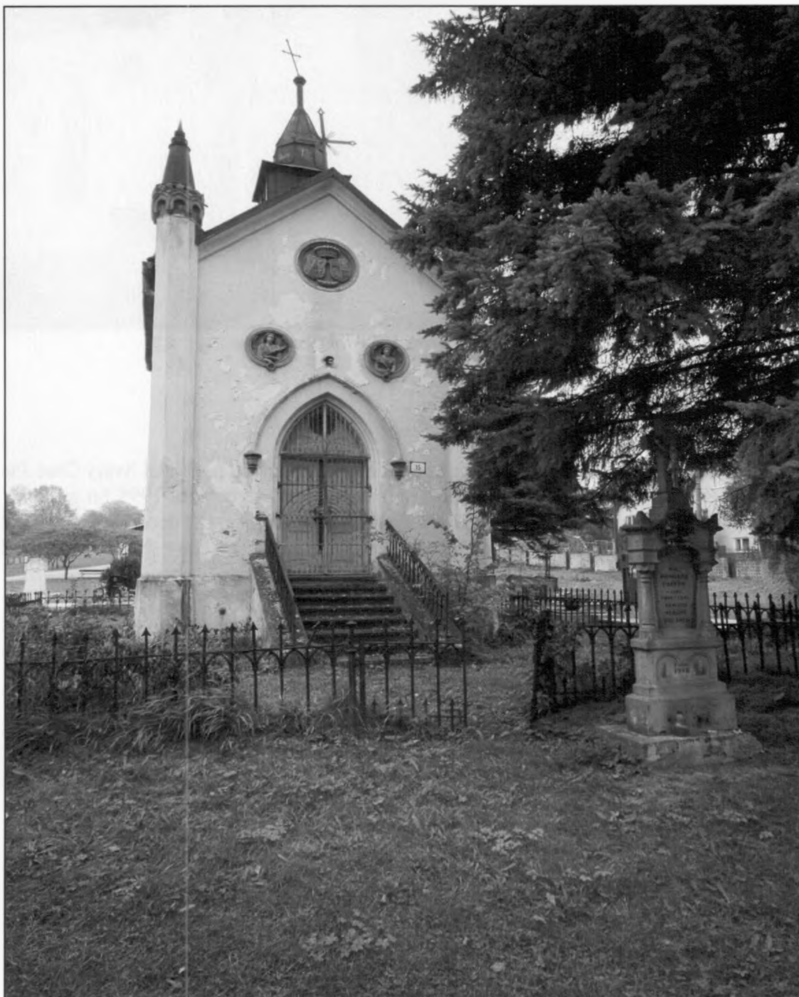
Kaplnka pred rekonštrukciou
