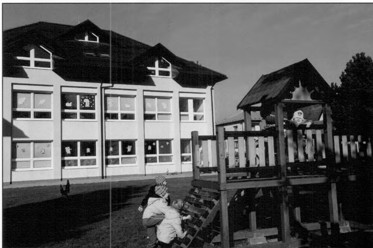
Budova MŠ po rekonštrukcii
