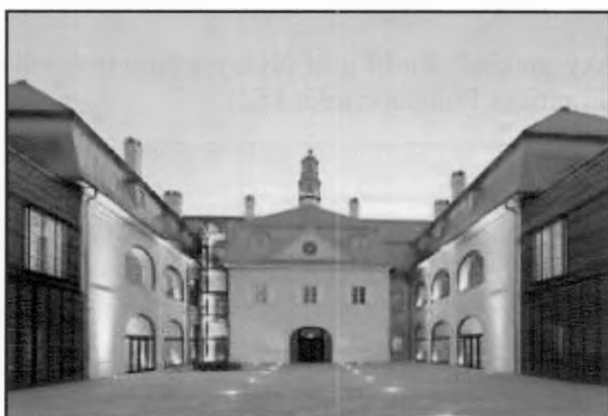
Hotel po rekonštrukcii
