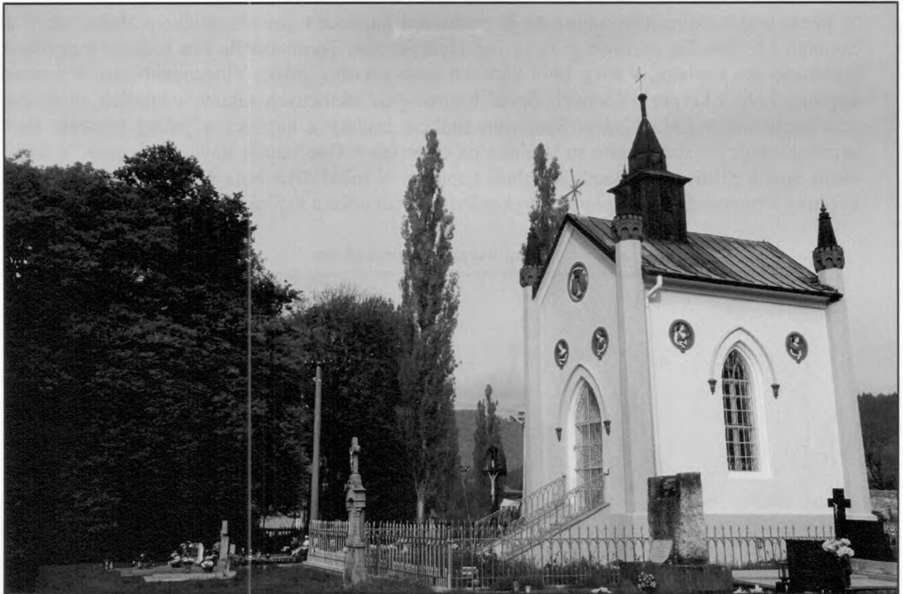
Zrekonštruovaná kaplnka na cintoríne
