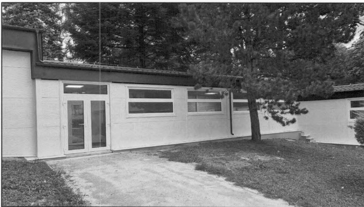
Spojovacia chodba do telocvične
