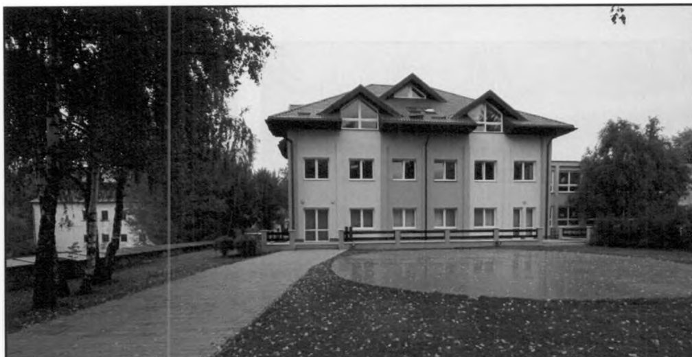
Budova kultúrneho domu po rekonštrukcii
