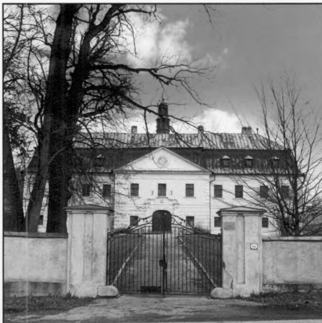
Budova barokového kaštieľa pred rekonštrukciou
