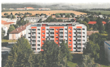
Obnova bytových domov | Obnova | 2022
