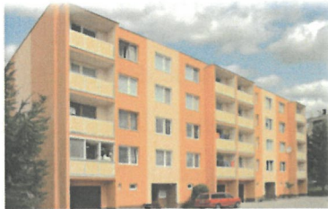
Obnova bytových domov | Obnova | 2012
