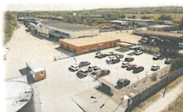
Priemyselné stavby | rekonštrukcia + novostavba | 2022
