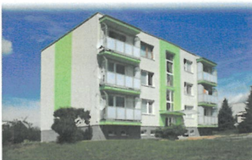
Obnova bytových domov | Obnova | 2012
