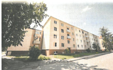
Obnova bytových domov | Obnova | 2022
