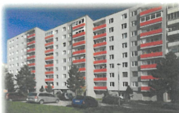
Obnova bytových domov | Obnova | 2013
