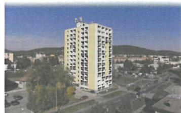
Obnova bytových domov | Obnova | 2019
