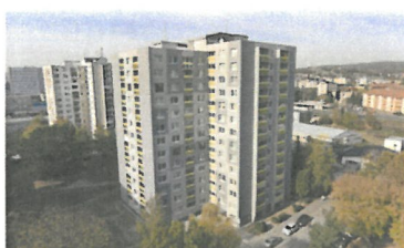
Obnova bytových domov | Obnova | 2019
