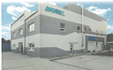
Priemyselné stavby | Rekonštrukcia | 2013
