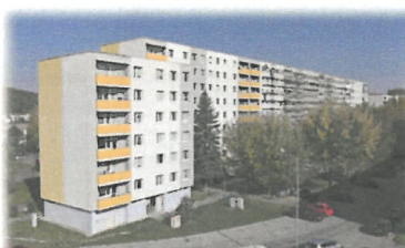
Obnova bytových domov | Obnova | 2019
