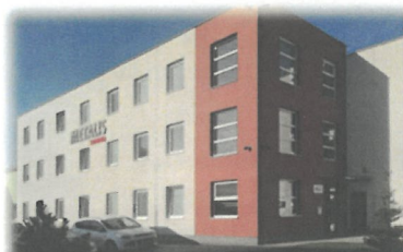
Priemyselné stavby | Rekonštrukcia | 2014
