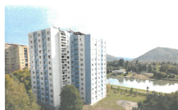
Obnova bytových domov | Obnova | 2017
