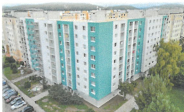
Obnova bytových domov | Obnova | 2024
