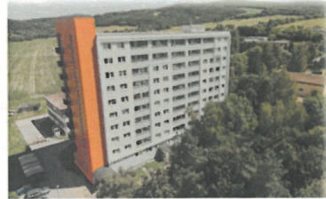
Obnova bytových domov | Obnova | 2024
