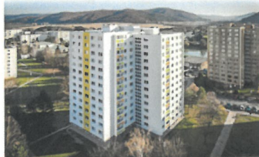
Obnova bytových domov | Obnova | 2016
