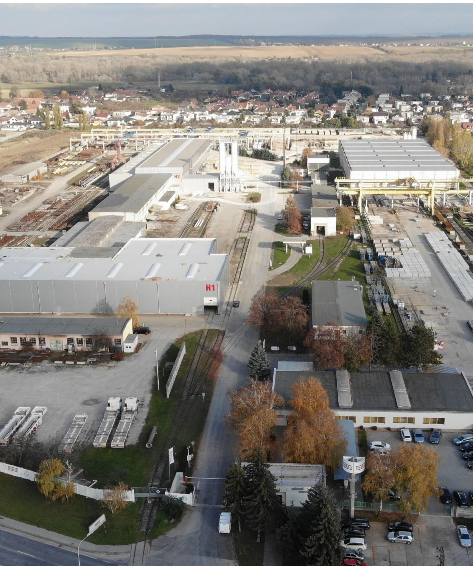
Závod STRABAG Sered, Výroba, doprava a montáž betonových prefabrikátů
