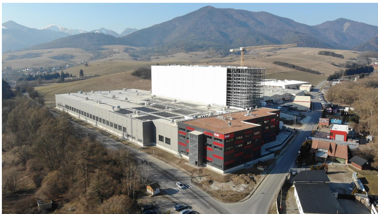
Výrobná-skladová hala HOVAL, Istebné
