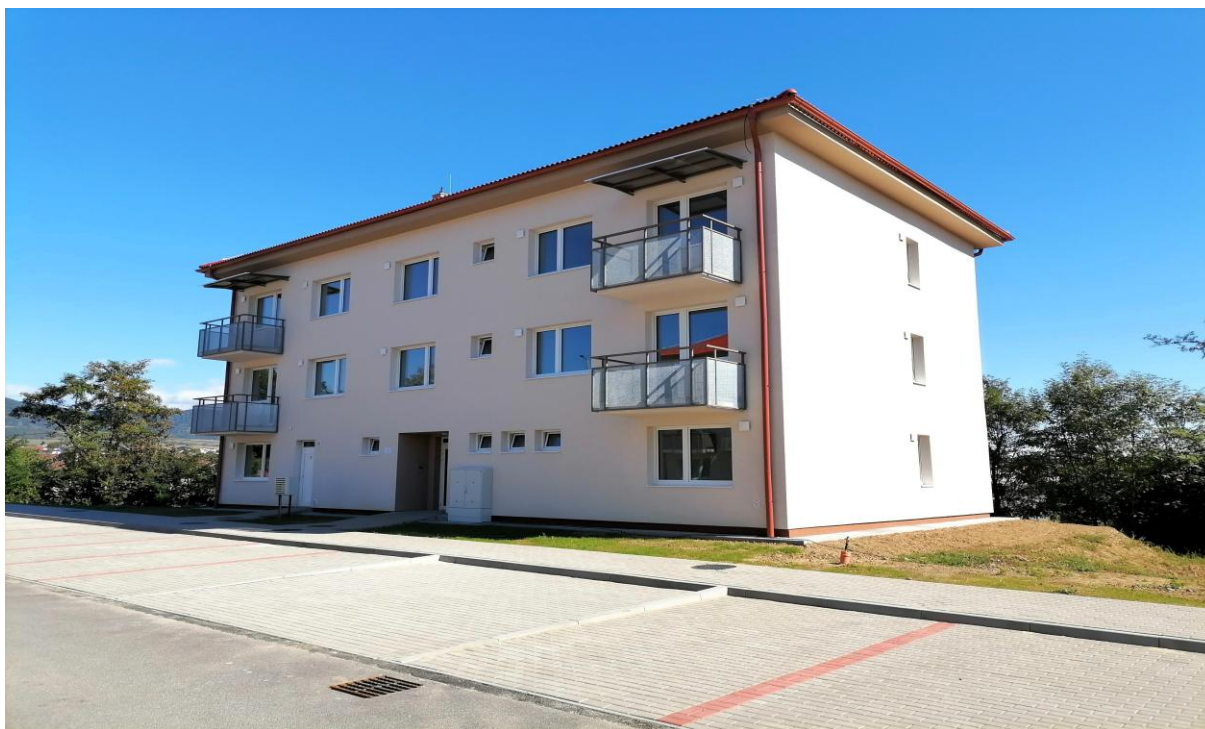
Obrázok 1 Výstavba nájomných bytov na ulici Mlynskej
