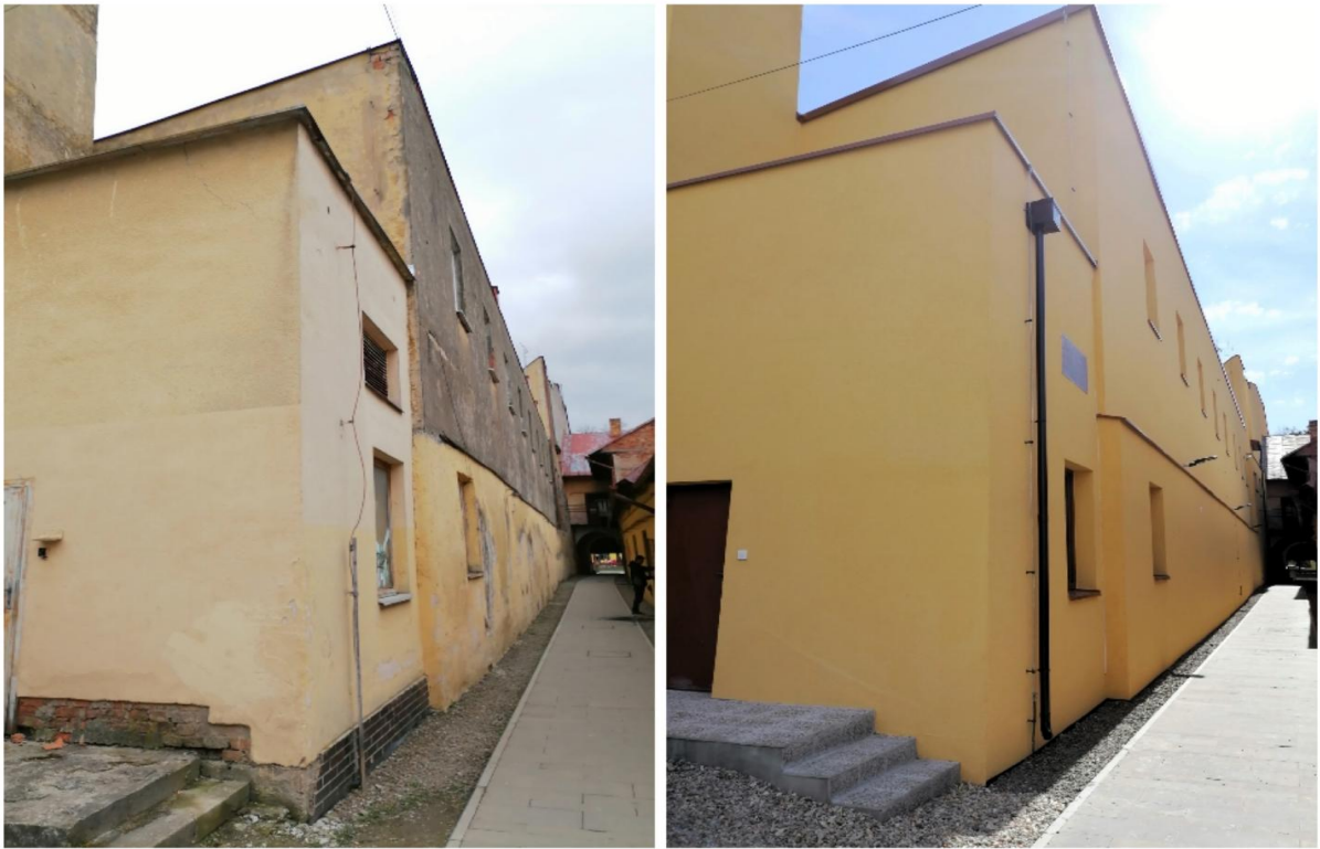
Obrázok 2 Rekonštrukcia Zimného štadióna – I. etapa
