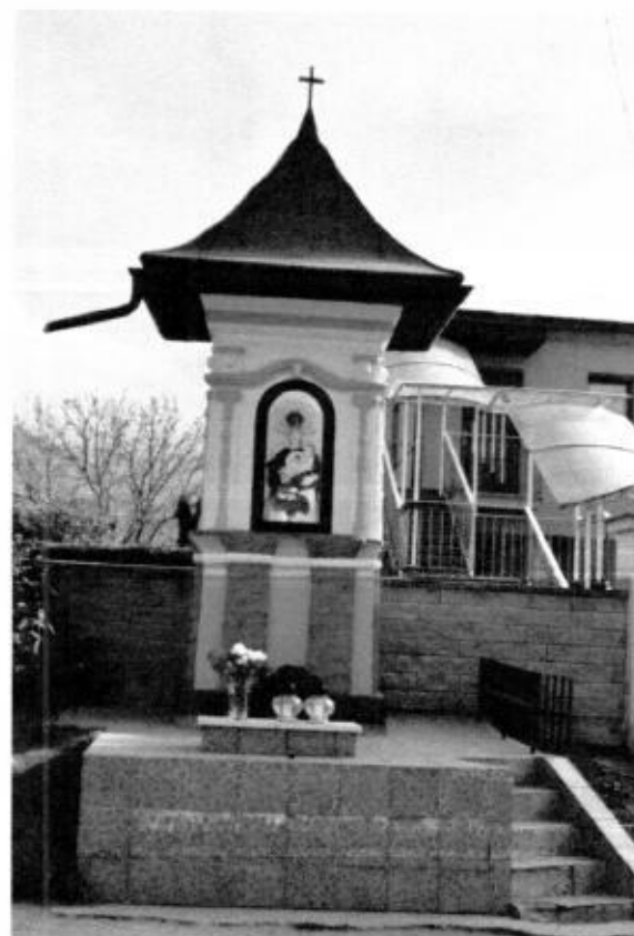
Obnovená kaplnka v roku 2018
