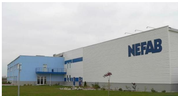
Obr. Výrobná hala po ukončení výstavby
