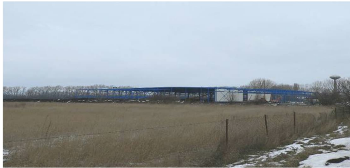
Obr. Výrobná hala počas výstavby
