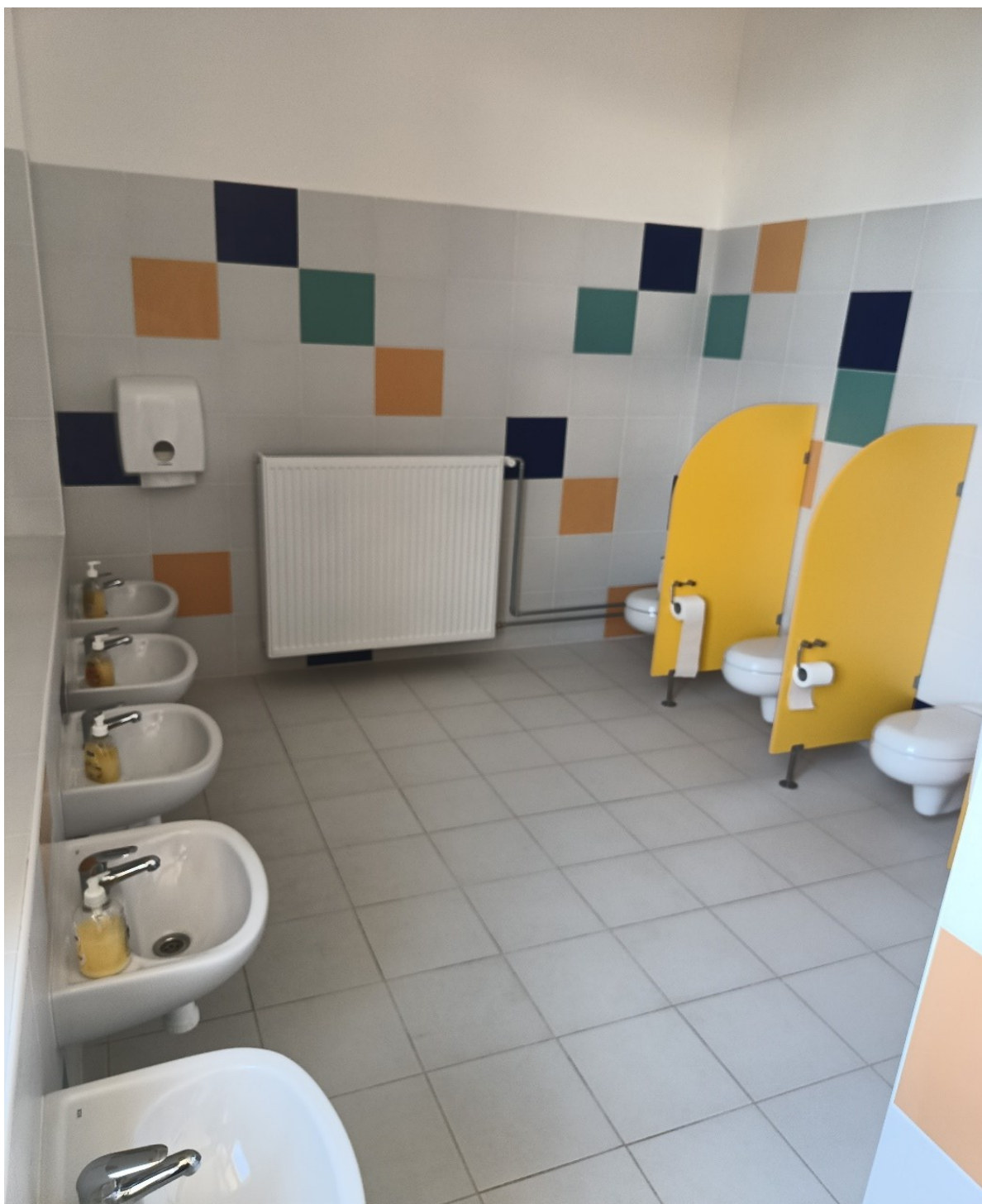
Obr. 4 Materská škola po rekonstrukcii- WC
