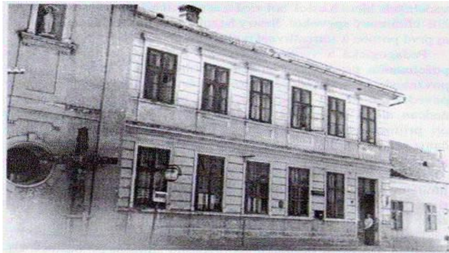
Budova kláštora sestier svätého Kríža v Pečeňadoch
