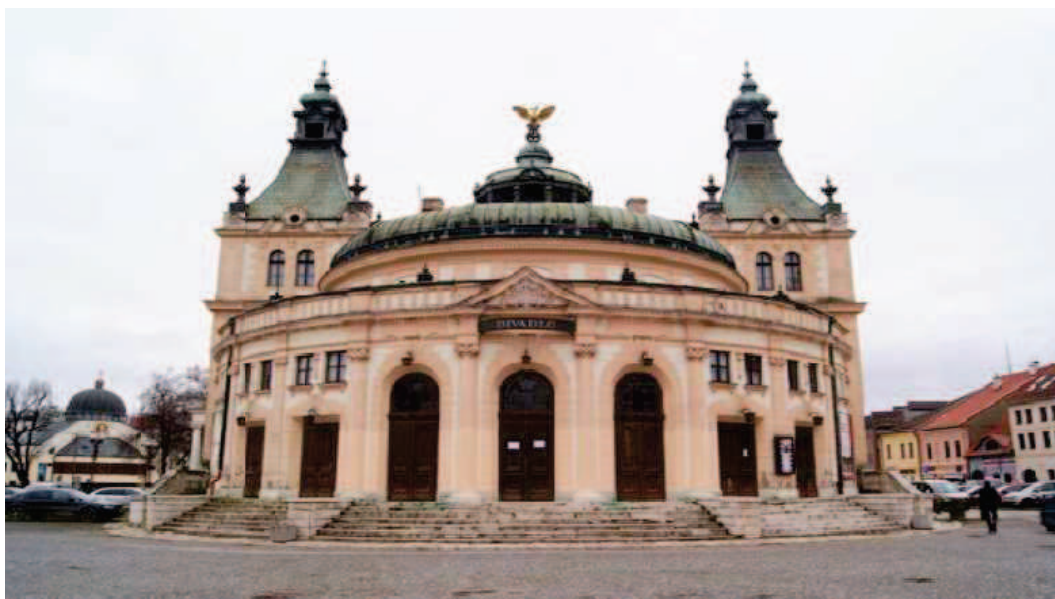
Obrázok č. 43 Reduta – príprava komplexnej obnovy objektu
