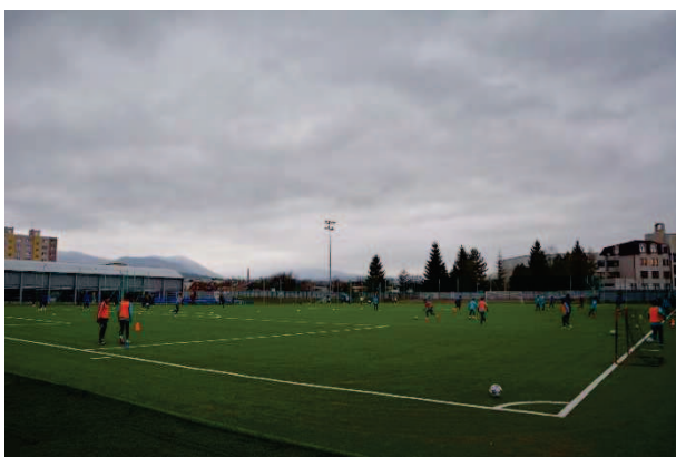
Obrázok č. 47 Umelá trávnatá plocha na futbalovom štadióne po modernizácii
