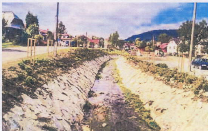
Stavba: "Ochrana pred povodňami"
