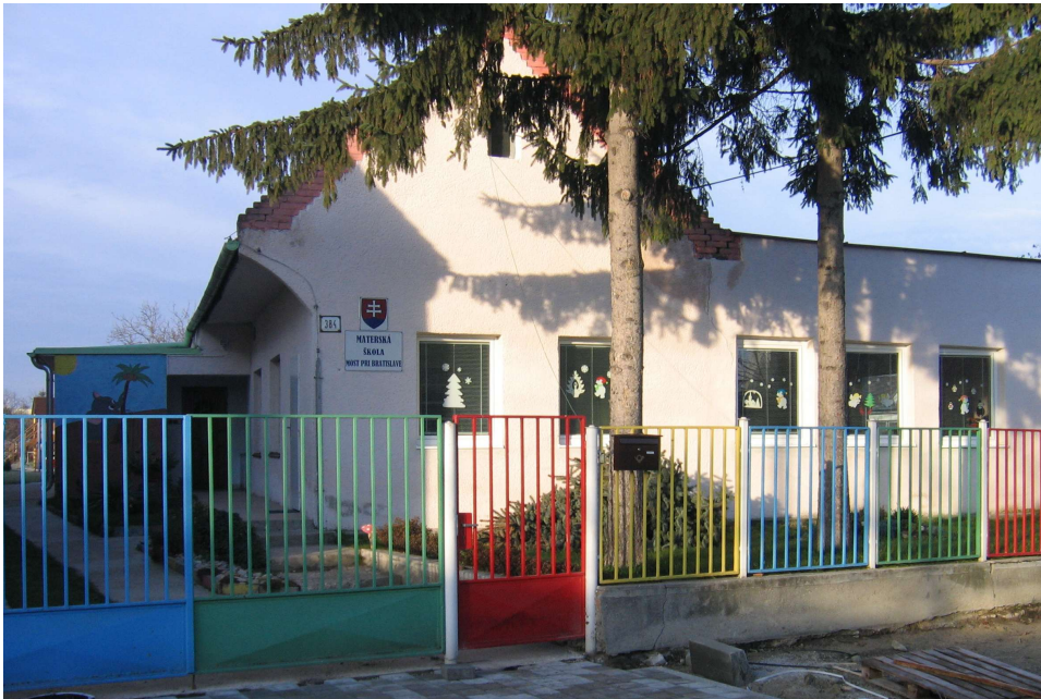
Materská škola, ul. 29. augusta 384, Most pri Bratislave
