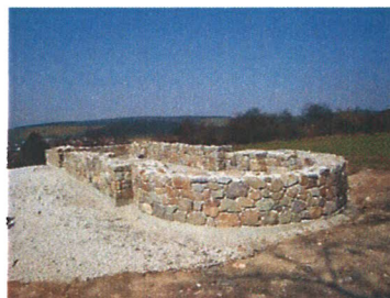
Základy zaniknutého kostola sv. Juraja
