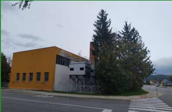
Rekonštrukcia kotolne BD Gen. Viesta 1666, Trenčín
