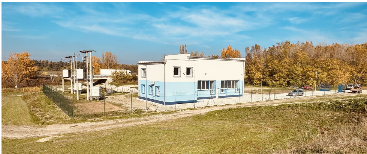
Čenkov - rekonštrukcia čerpacej stanice
