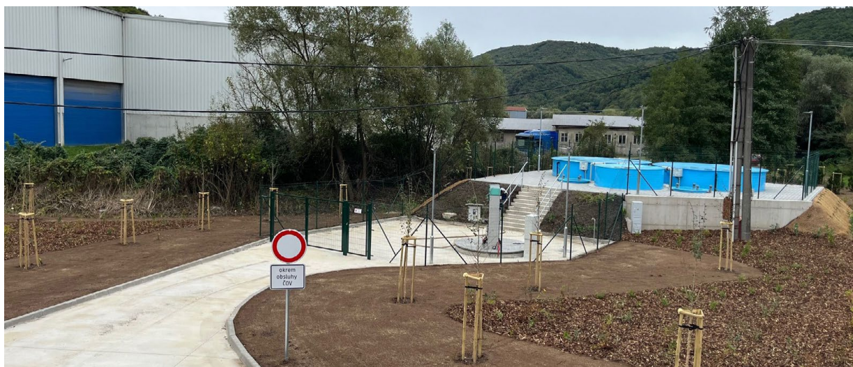
Prenčov - rozšírenie kanalizácie a ČOV
