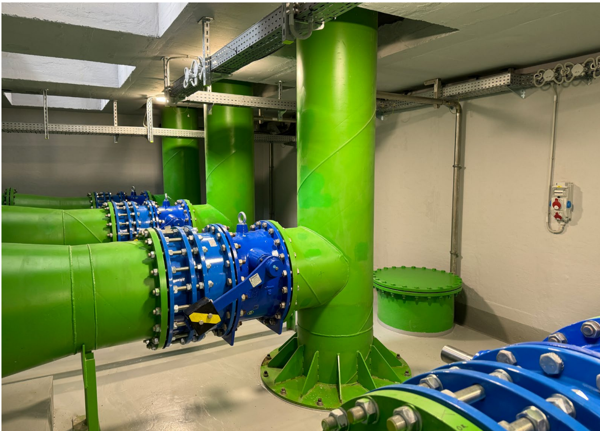
Čenkov - rekonštrukcia čerpacej stanice
