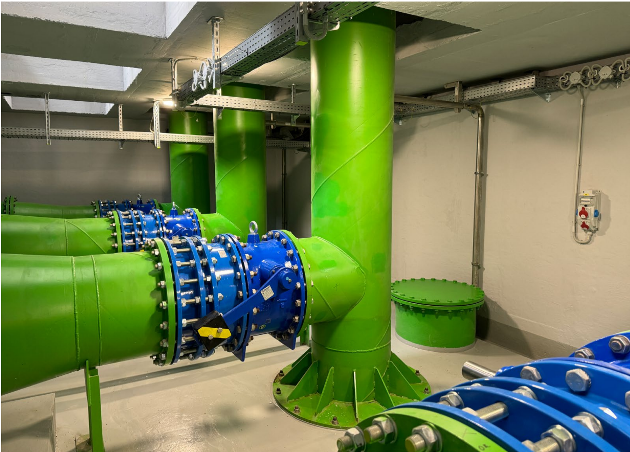
Čenkov - rekonštrukcia čerpacej stanice
