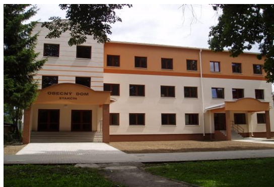
Turistická ubytovňa* Obecný dom
