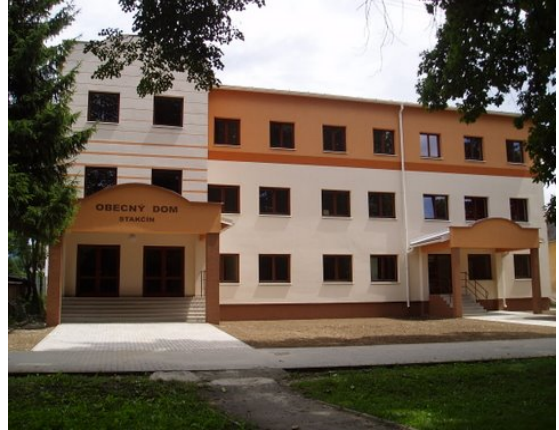
Budova Obecného domu (2007)
