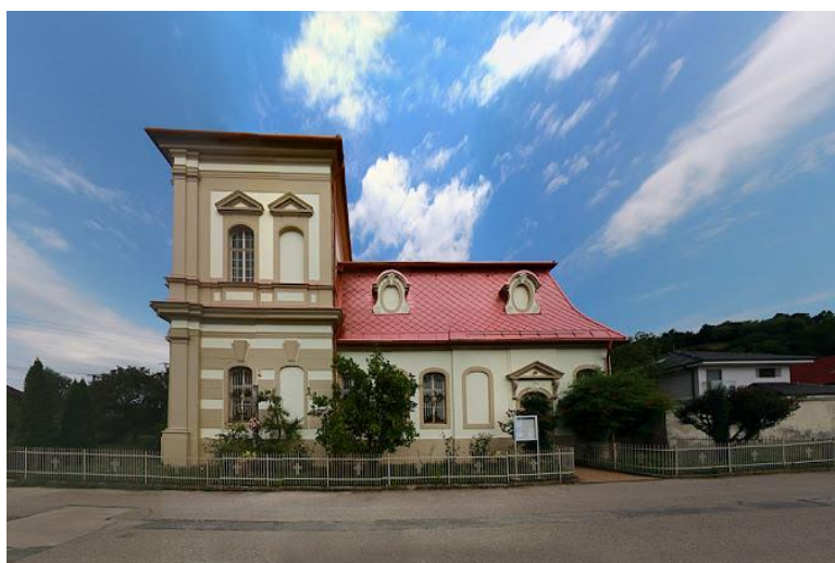
Kaplnka Nepoškvrneného počatia Panny Márie
