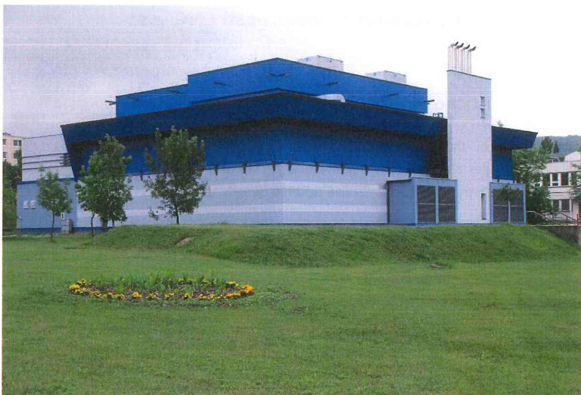
Budova Dátového centra PERPETUUS v Devínskej Novej Vsi
