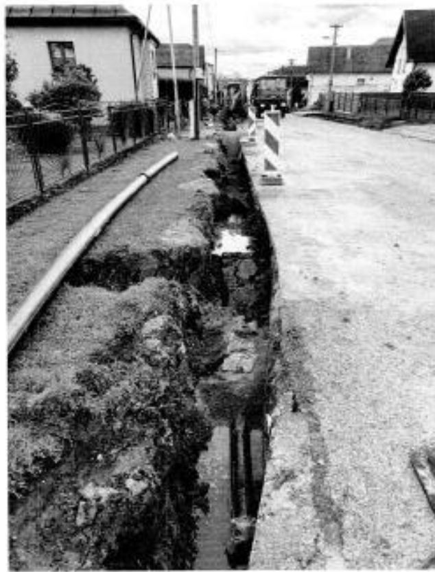
Tvrdošín, ul. M. R. Štefánika. Z dôvodu plánovej rekonštrukcie miestnej cesty bola vopred prevedená potrebná oprava poruchového vodovodu HDPE DN 160 v dĺžke viac ako 512 m.
