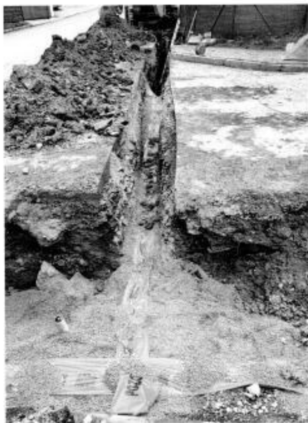
Tvrdošín, ul. M. R. Štefánika. Z dôvodu plánovej rekonštrukcie miestnej cesty bola vopred prevedená potrebná oprava poruchového vodovodu HDPE DN 160 v dĺžke viac ako 512 m.
