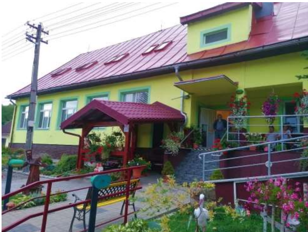
Obr. 1 Budova zariadenia pre seniorov – GERIA, n. o.
