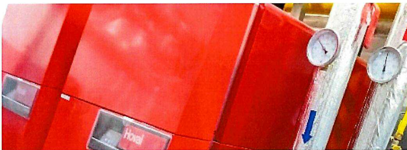
Rekonštrukcia domovej kotelne Raymanova, Prešov
