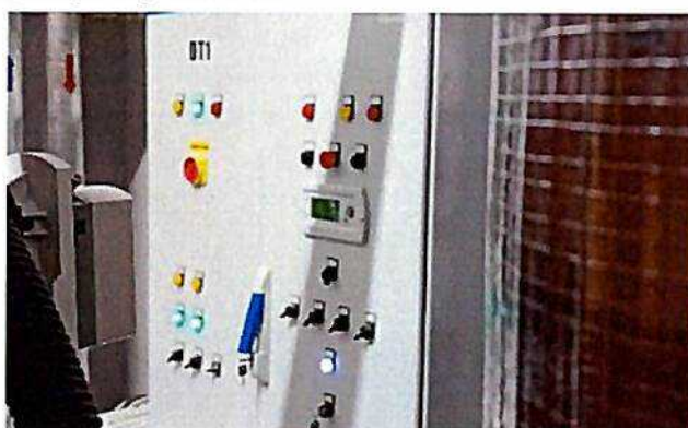
Rekonštrukcia domovej kotelne Slovenská 40, Prešov
