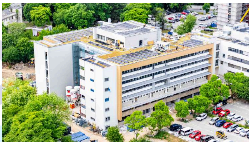
REKONŠTRUKCIA LŮŽKOVÉHO PAVILÓNU A HOTFLOOR – NEMOCNICA AGEL LEVICE
