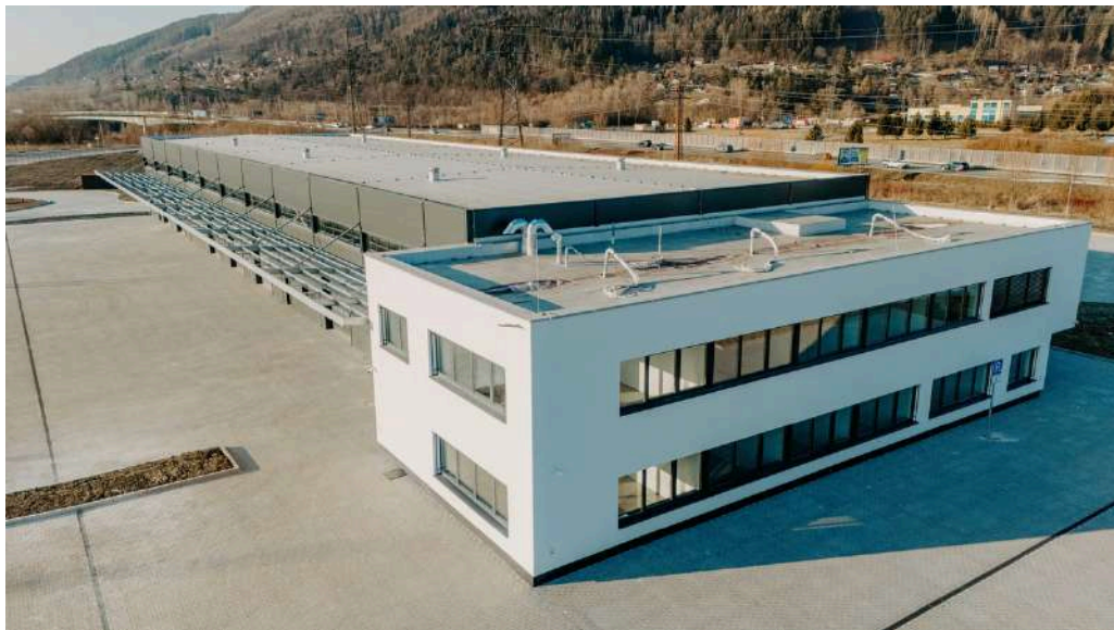
VÝSTAVBA LOGISTICKÉHO CENTRA TEPLIČKA NAD VÁHOM
