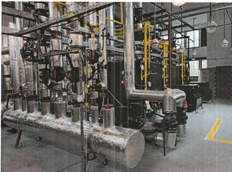
Výmena kotla K1 v plynovej kotolni PK K3 Hájik
