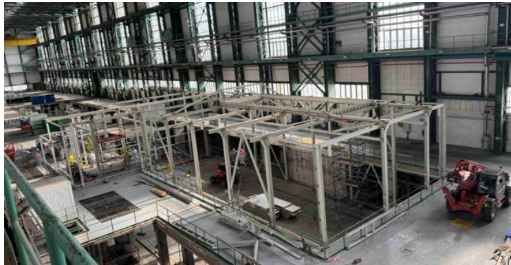
Projekt D4.2: Demobilizácia a demontáž pracoviska fragmentácie parogenerátorov
