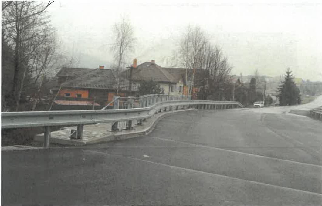
Most M230, ev. č. 526-048, po rekonštrukcii
