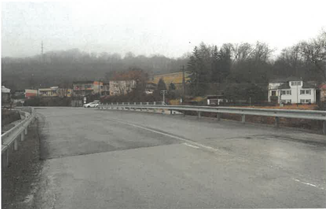
Most M230, ev. č. 526-048, po rekonštrukcii
