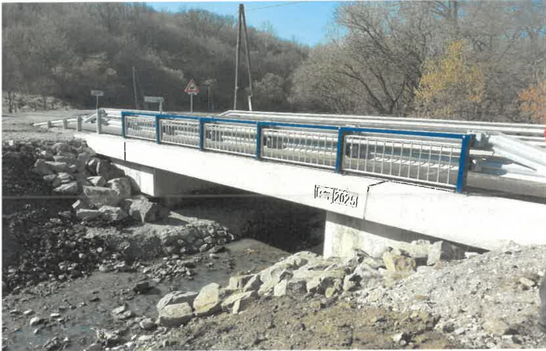
Most M6766 (ev. č. 2561-003), po rekonštrukcii
