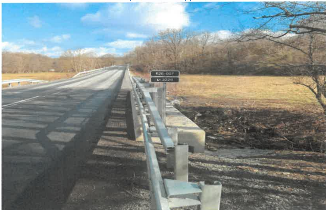
Most M3229, ev. č. 526-007, po rekonštrukcii
