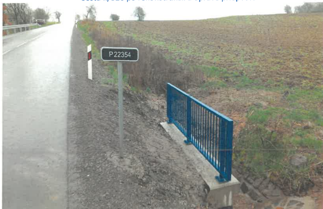
Cesta II/526 po rekonštrukcii a oprave priepustov
