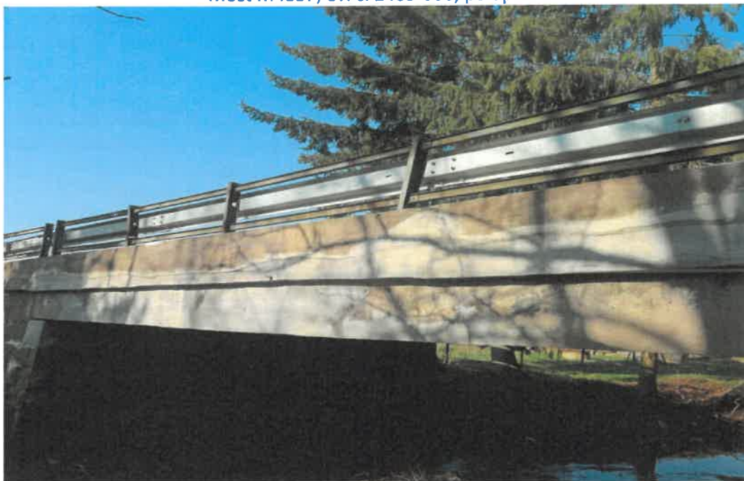
Most M4857, ev. č. 2483-006, po oprave
