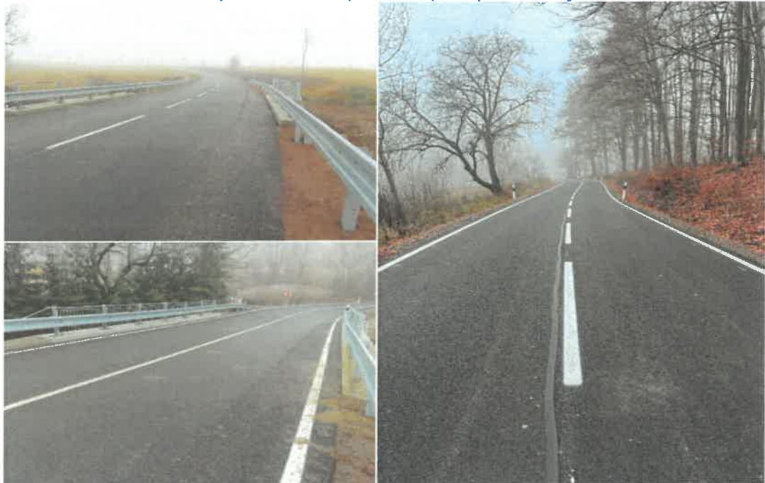
Most M10555, ev. č. 527-034, a cesta II/527 po celkovej rekonštrukcii
