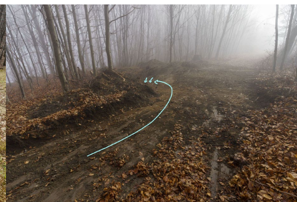
Porovnanie stavu PRED a PO realizácii: metóda jama-hrádza-jama, protierózna stabilizácia
