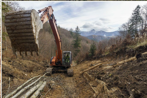
Porovnanie stavu PRED a PO realizácii: metóda jama-hrádza-jama, protierózna stabilizácia
