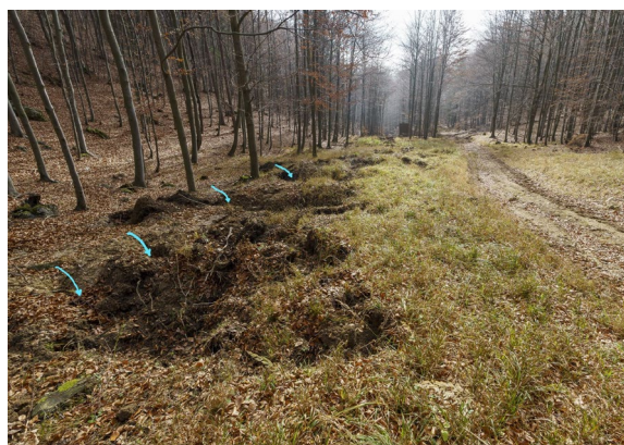
Infiltračné opatrenia typu šachovnica a terénna vlna
