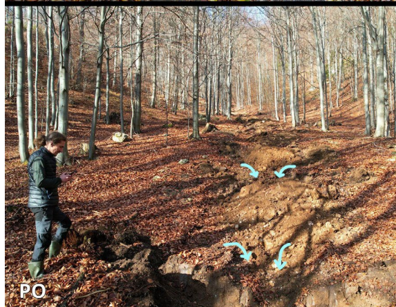
Porovnanie stavu PRED a PO realizácii: metóda jama-hrádza-jama, protierózna stabilizácia
