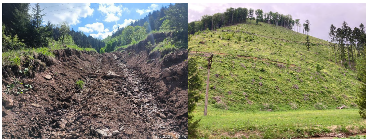
Prístupová cesta ktorá odvodňuje holinu na strmom svahu (zdroj: Aqua Terra Innova, ďalej len "ATI", 2025)
