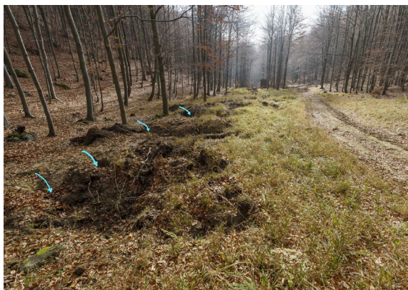
Infiltračné opatrenia typu šachovnica a terénna vlna
