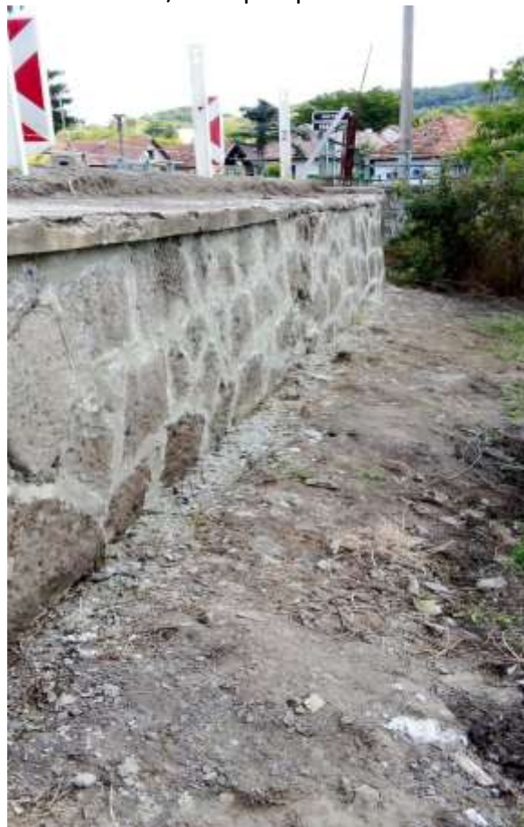
Jabloňovce III/1587 po opravu
