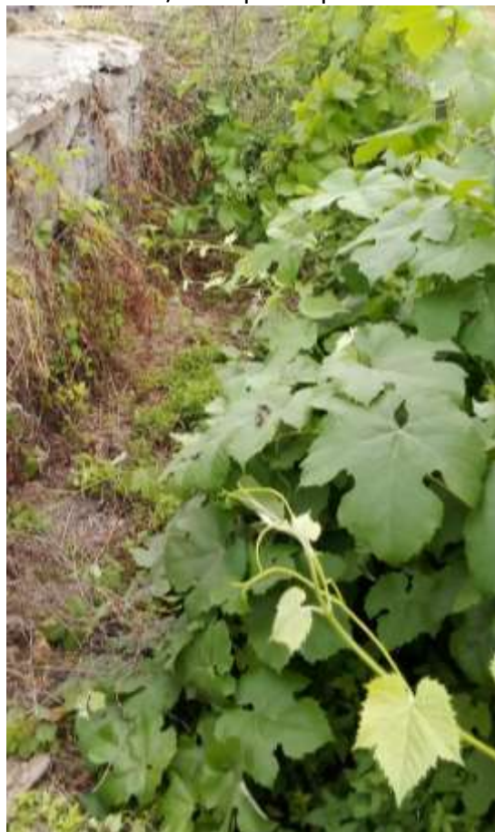
Jabloňovce III/1587 pred opravou
