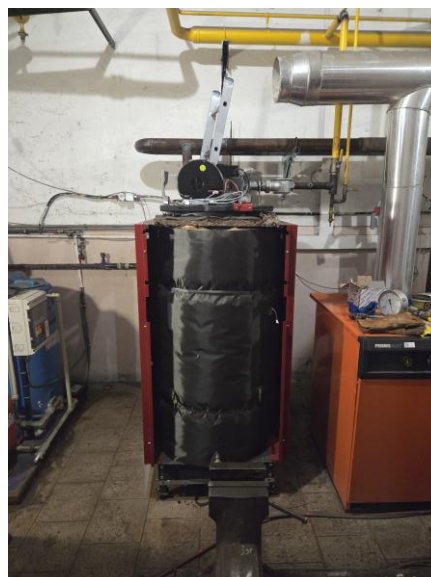
Oprava kotla, plynového zapojenia, komínovej vložky a dymovodu v kotolni Dom Kultúry
