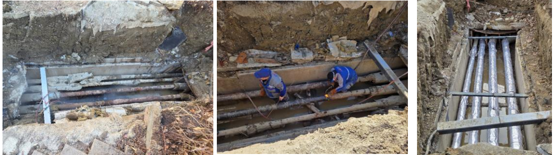
Opravy havarijných stavov tepelných rozvodov
