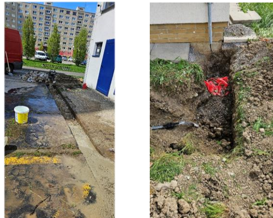
Oprava uzemnenia bleskozvodnej sústavy na OST PK 1/III, Podjavorinskej ul.
