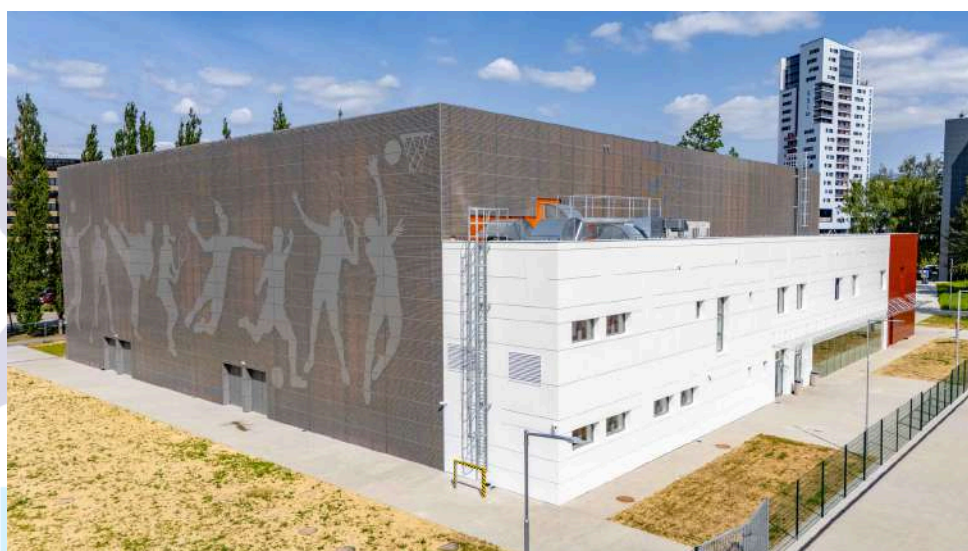
VÝSTAVBA - ŠPORTOVÉ CENTRUM - ŽILINSKÁ UNIVERZITA
