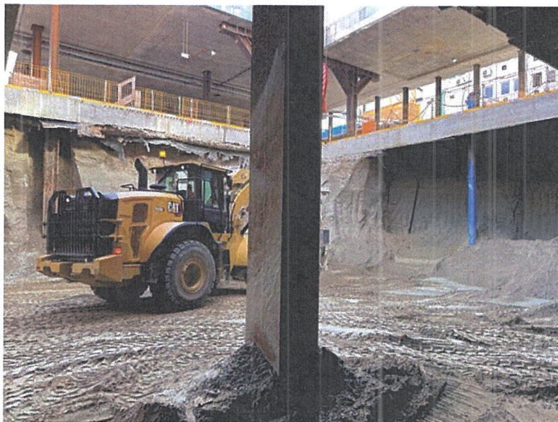
Tunnel Hauptbahnhof München
