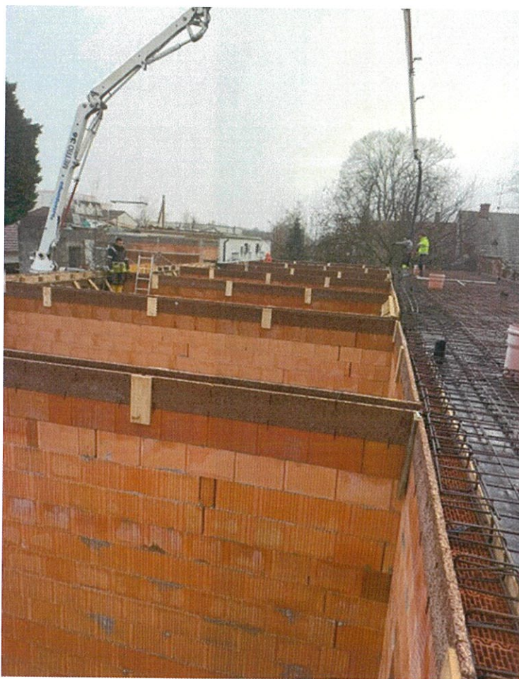
Obr.: Výstavba stavebného objektu SO02
