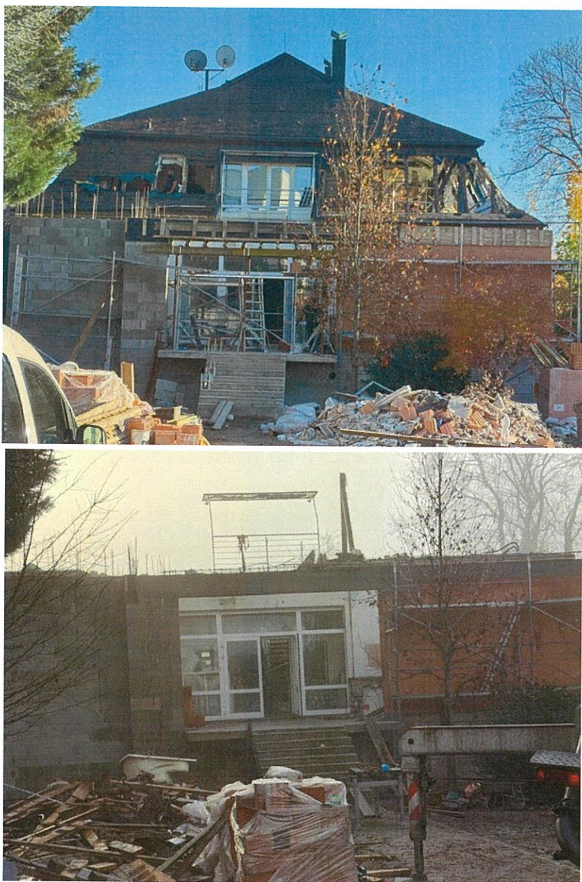
Obr.: Rekonštrukcia stavebného objektu SO01
