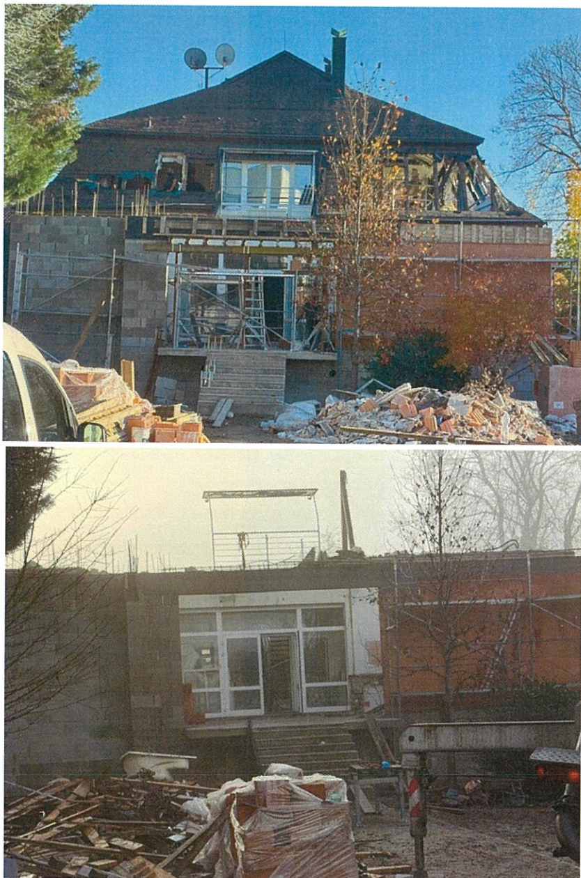
Obr.: Rekonštrukcia stavebného objektu SO01
