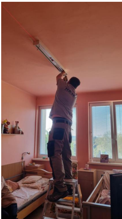
výmena starého osvetlenia za LED svetidlá
