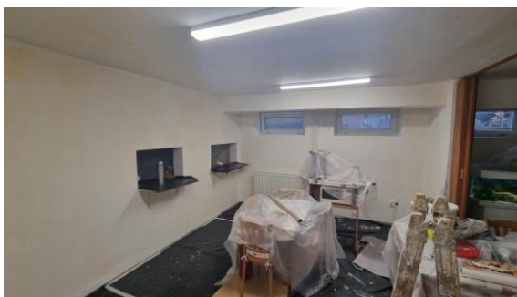
maľovanie interiéru počas plnej prevádzky
