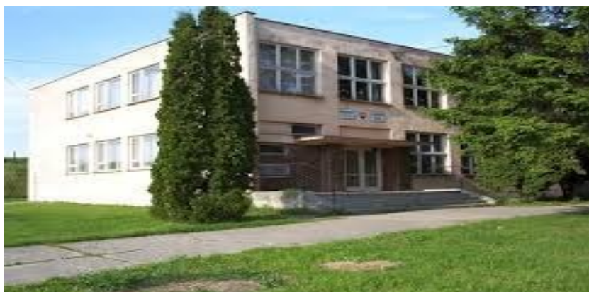
Budova materskej školy
