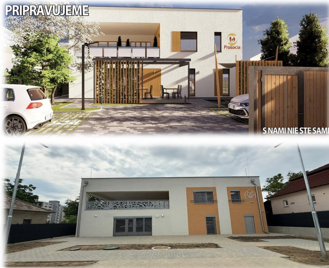
Obrázok 8 Výstavba ambulantného špecializovaného zariadenia
