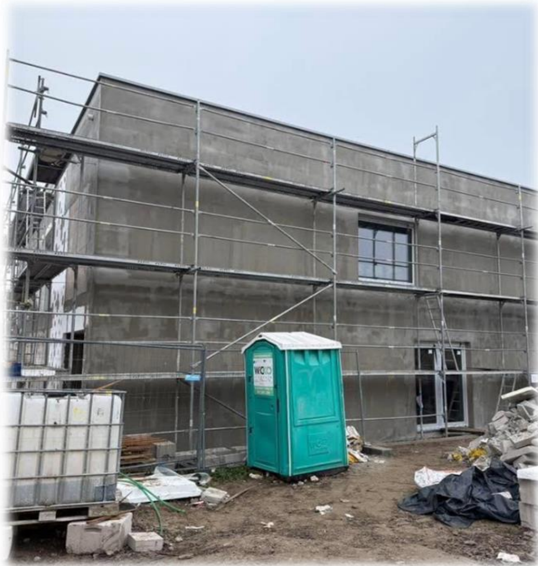
Obrázok 20 Stavebné práce koncom roka 2025 – Ambulantné zariadenie
