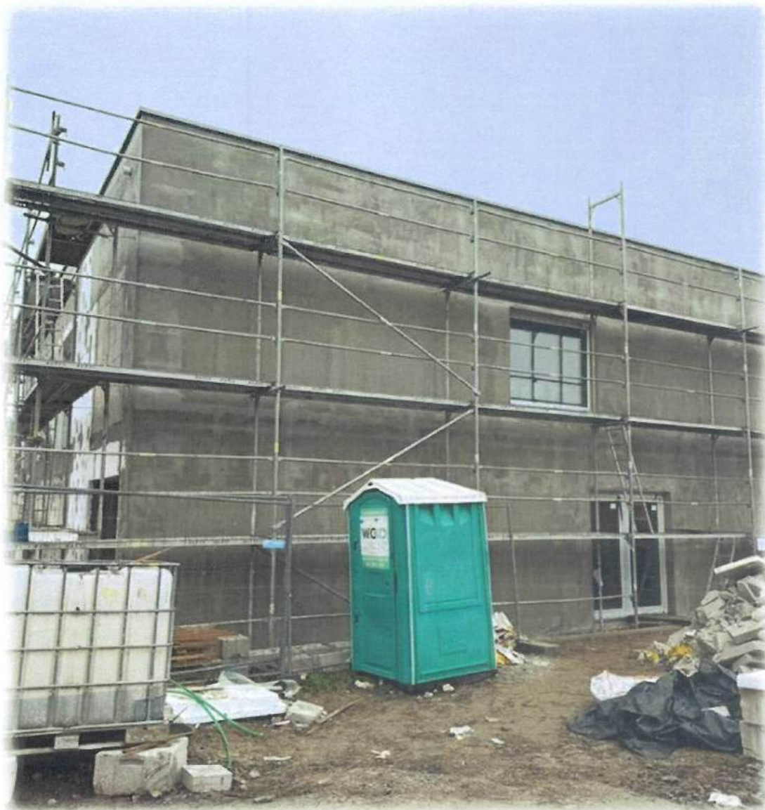
Obrázok 20 Stavebné práce koncom roka 2025 – Ambulantné zariadenie
