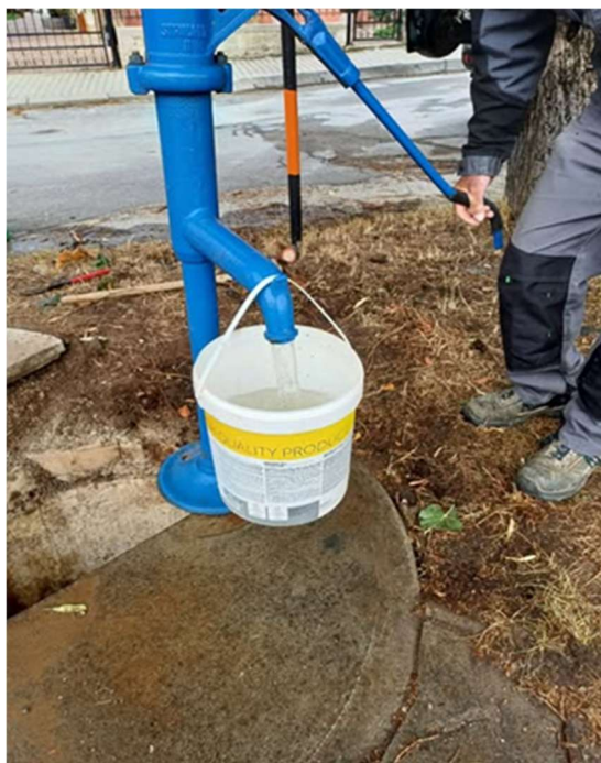
Obnovenie studne v obci
