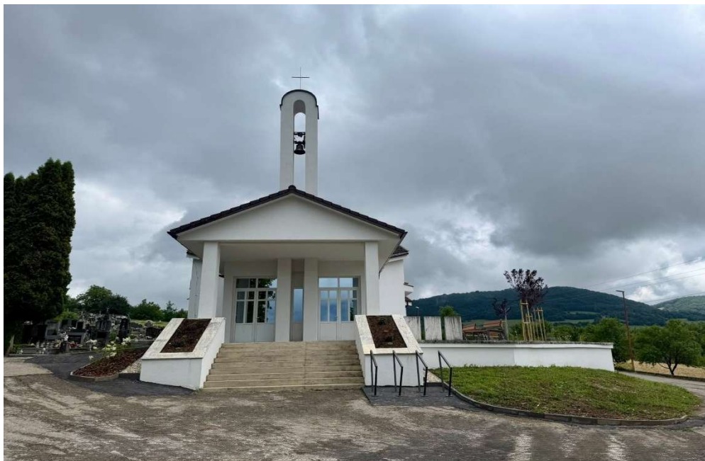
Stavebné práce na stavbe „ – Dom Nádeje- cintorín Lipina“
