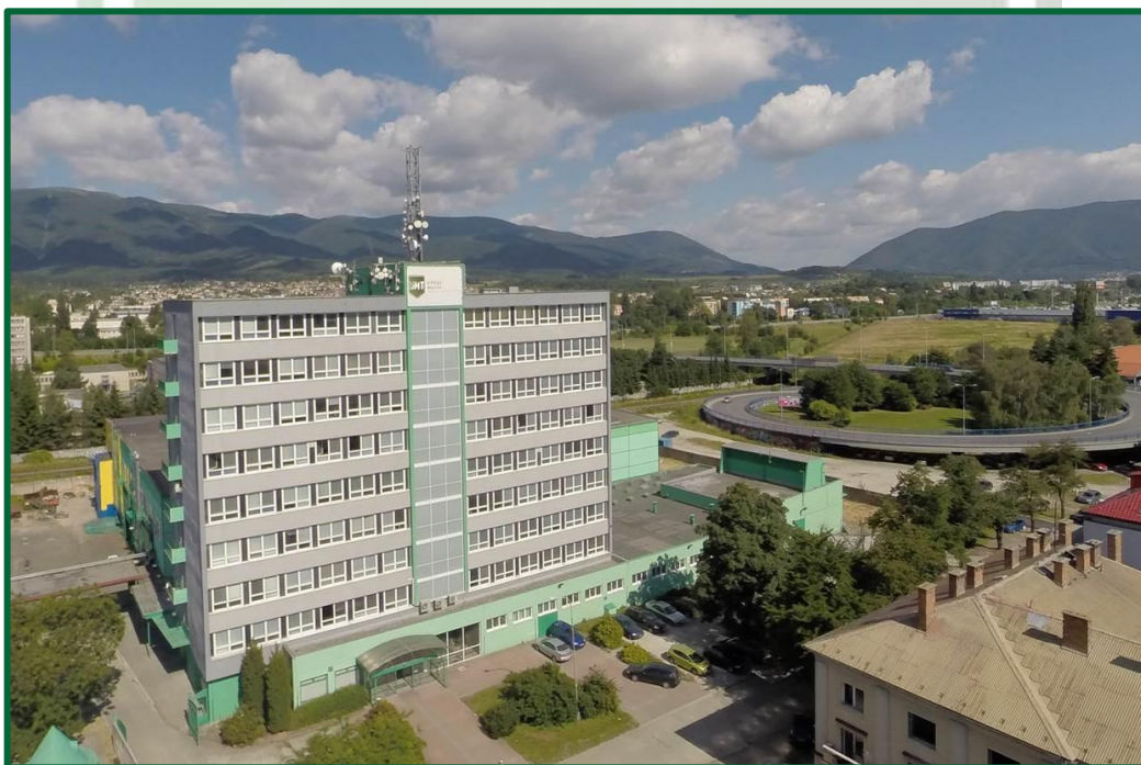
Pohľad na administratívnu budovu
